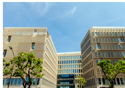
Immeuble Lebon Lamartine 126/138 avenue de Stalingrad - Villejuif (94)
