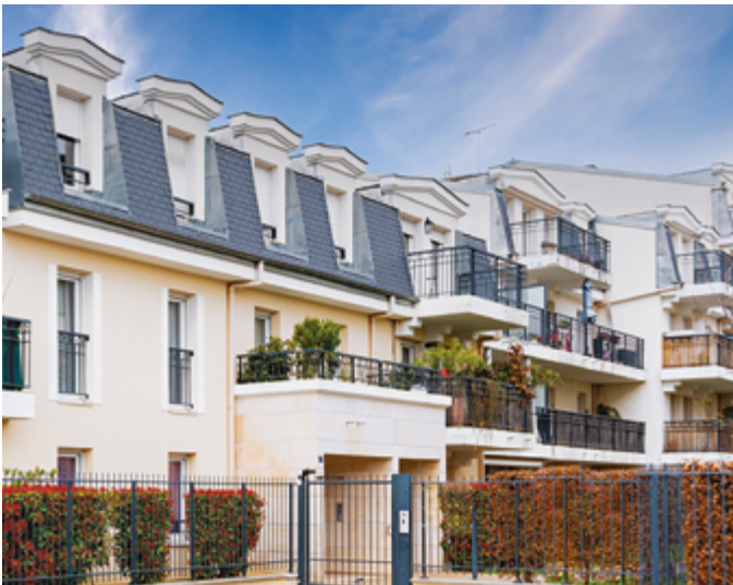
▲ Saint-Ouen l'Aumône (95) - 29 rue du Général Leclerc
