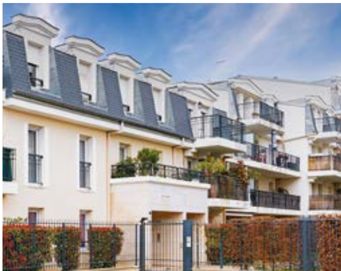
▲ Saint-Ouen l'Aumône (95) - 29 rue du Général Leclerc
