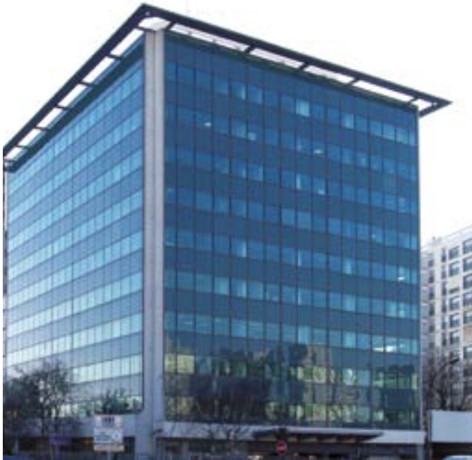
▲ 1, boulevard H. Marqués - Ivry-sur-Seine (94)
